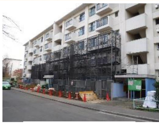
耐震補強工事施工中
