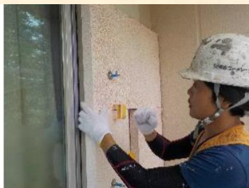
外断熱工事施工風景
