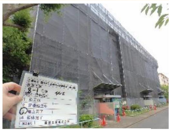
大規模修繕工事施工中
