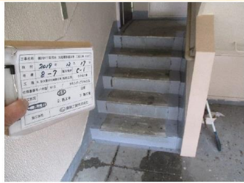
階段室 防水施工中
