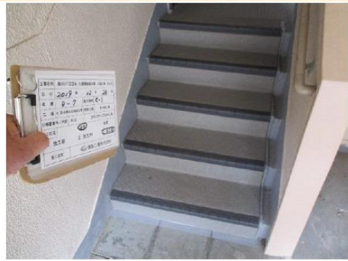
階段室 防水施工後
